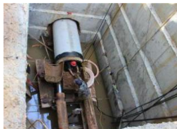
(e) 深基坑和地下管沟
